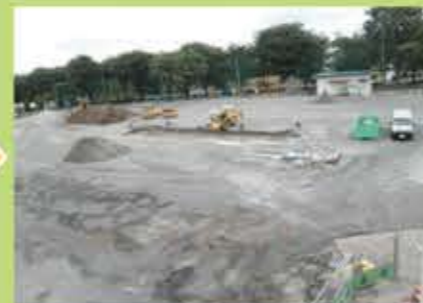
平成28年8月 芝生化工事中
