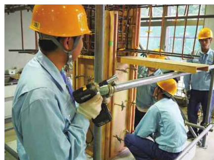
コンクリート型枠の製作
