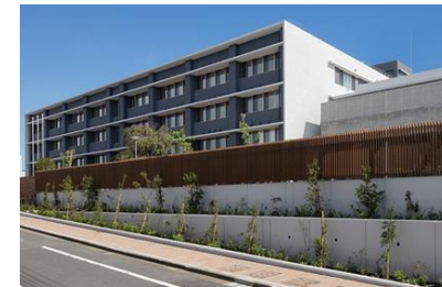
都立学校の外構における木柵整備
