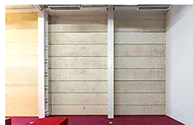
コンクリート 出典：大成建設株式会社
