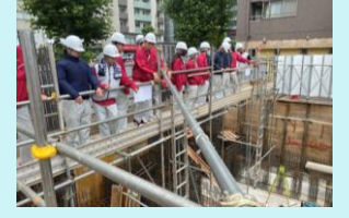
【建設現場の見学会】
