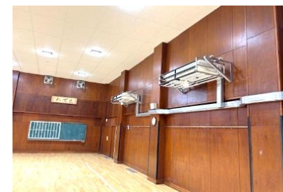
都立高校武道場の空調整備
