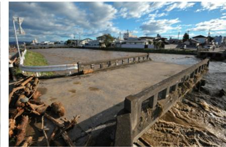
2019年 台風19号で川の増水により崩落した橋（栃木県）
