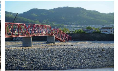
2019年 台風19号で川の増水により崩落した鉄橋（長野県）
