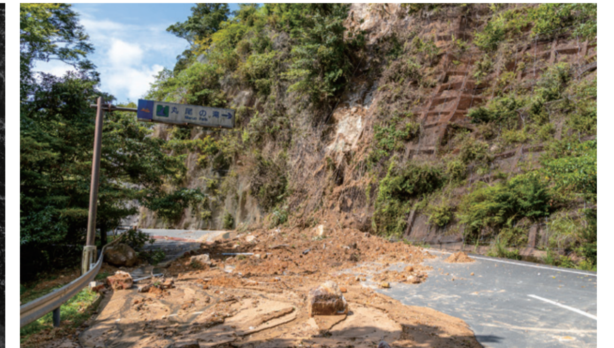
2022年 台風第14号被害の土砂崩れ (鹿児島県)
