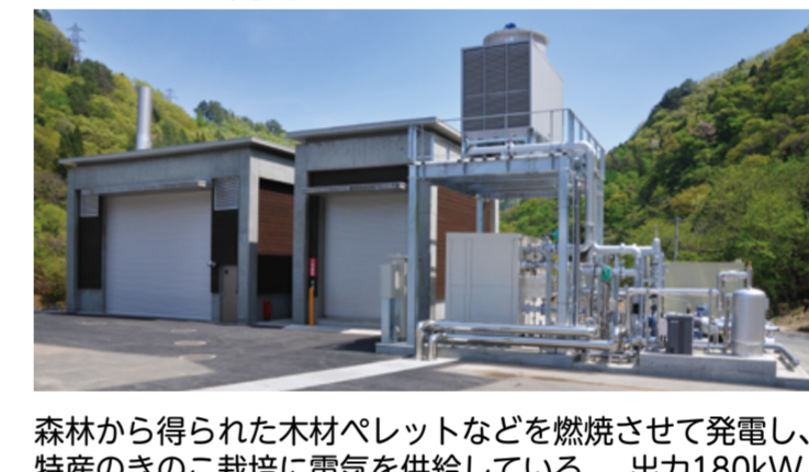
森林から得られた木材パレットなどを燃焼させて発電し、特産のきのこ栽培に電気を供給している。出力180kW
