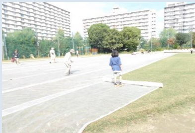
芝生養生シート貼り
