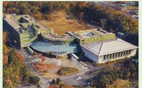
全棟：築36年（昭和63年竣工、平成17年改修）
