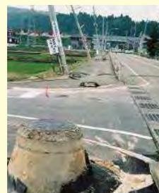
液状化で突出したマンホールと倒れた電柱（平成16年新潟県中越地震）
