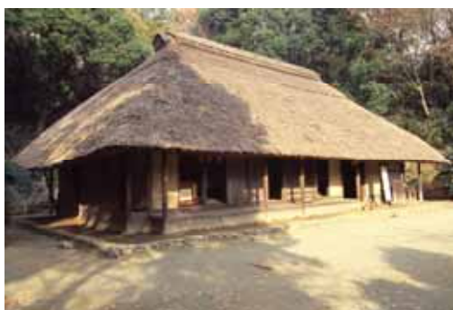
茅葺屋根の農家 (「北村家住宅」川崎市立日本民家園)
