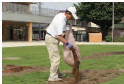
③ 補植地を事前にほぐす、改良土を加えるなどします。
