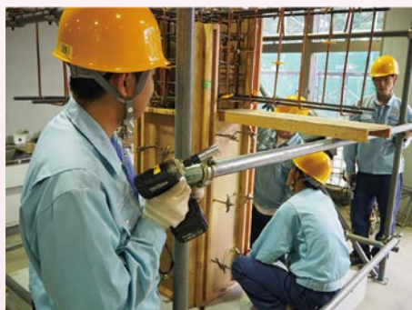
<コンクリート型枠の製作>
