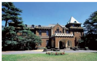
旧前田家本邸(洋館・目黒区) 修理後初公開
