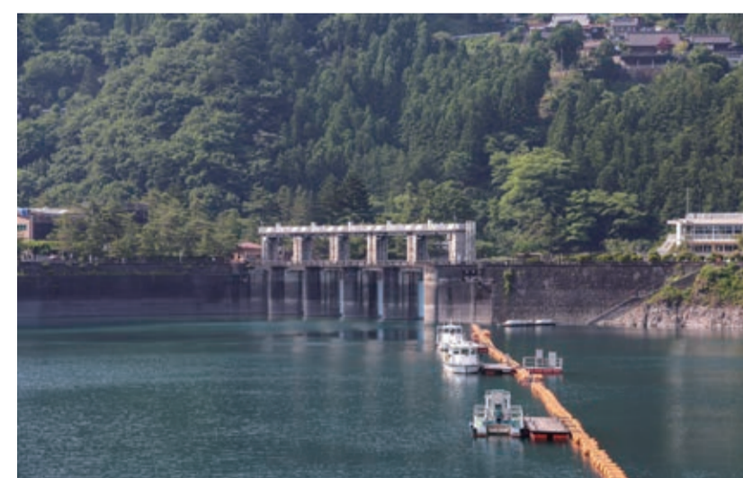
小内川ダム（東京都西多摩郡奥多摩町）
