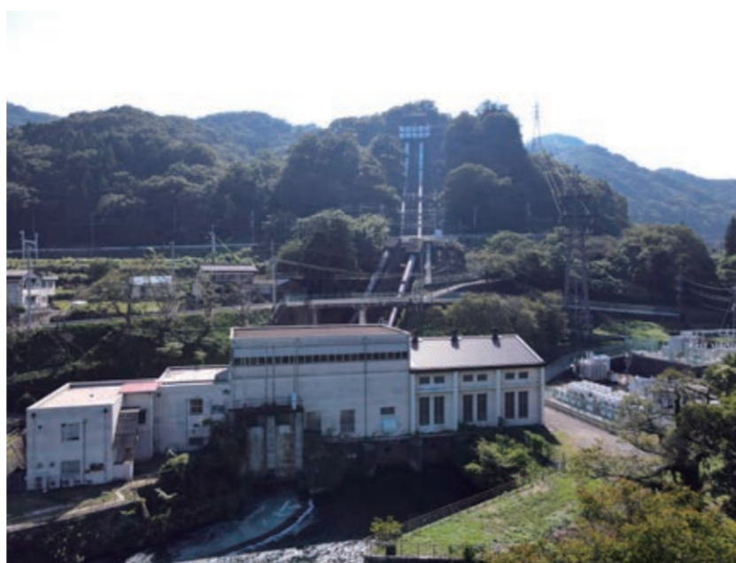
駒橋発電所（山梨県大月市） 写真提供：東京電力
