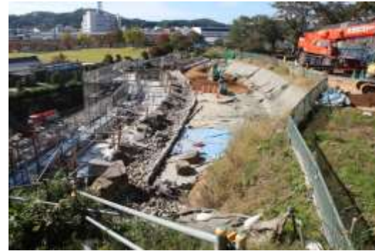
【竹之丸南面 石積み施工状況】 (平成28年10月24日現在)
