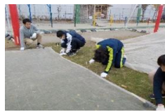
③シート敷き作業
