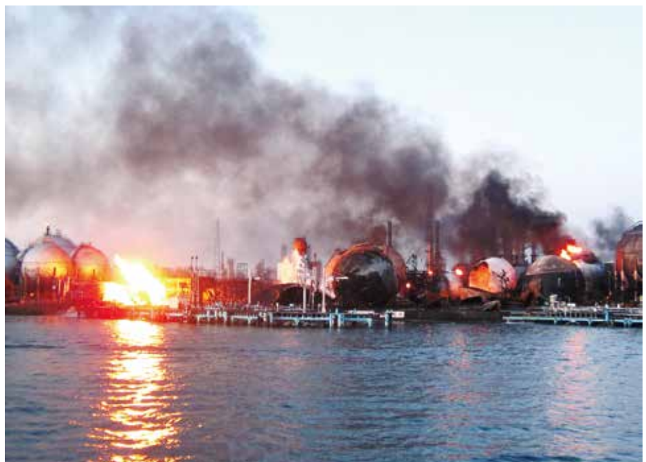
地震による石油タンクの火災 [東日本大震災 平成23年(2011)千葉県市原市]
