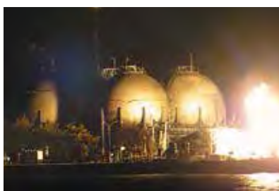
石油施設で発生した火災(千葉県市原市)
