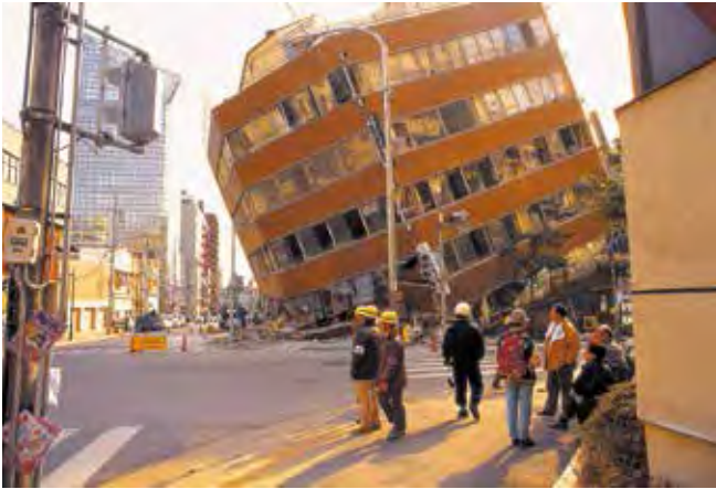
1階部分が崩れ、傾いたビル [阪神・淡路大震災 平成7年(1995)1月]
